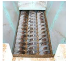
Einbau in Austragsschnecke (Holzkraftwerk)
